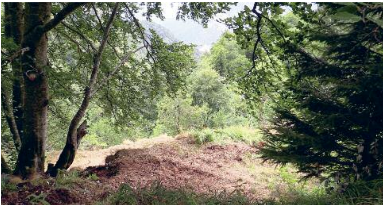
Lavori di ripristino antichi terrazzamenti di Luserna
