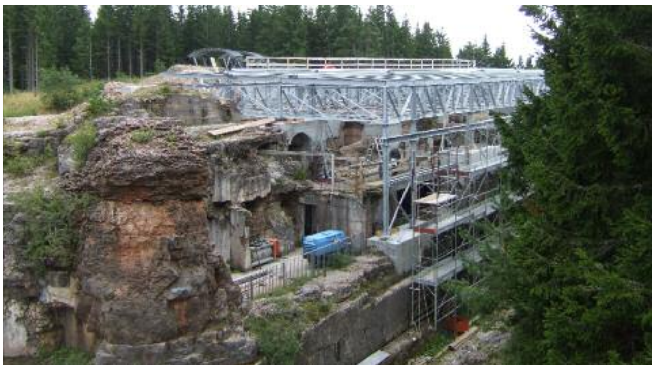
I lavori di recupero del Forte Werk Lusérn
