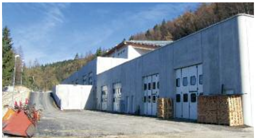
Il piano terreno del Centro Artigianale asfaltato
