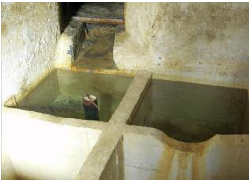
I lavori di ammodernamento dell'acquedotto di Lusérn cominceranno nella primavera/estate 2014
